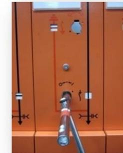
1. Schalten Sie den Erdungsschalter wie auf dem linken Bild in Pfeilrichtung in die AUS-Stellung. Der Schalterstellungsanzeiger des Erdungsschalters zeigt nun einen waagerechten Strich.
