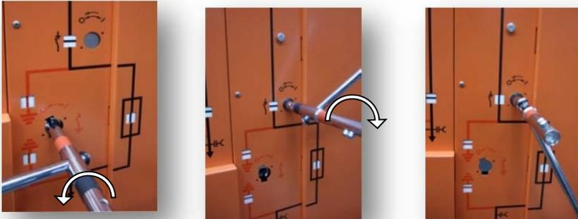
1. Schalten Sie den Erdungsschalter wie auf dem linken Bild in Pfeilrichtung in die AUS-Stellung. Der Schalterstellungsanzeiger des Erdungsschalters zeigt nun einen waagerechten Strich.
